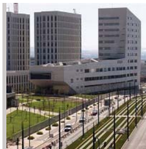
Vista exterior de la Facultad
